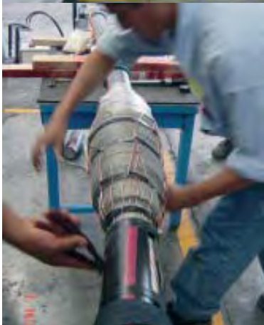
JS 123 kV, Mexico.
