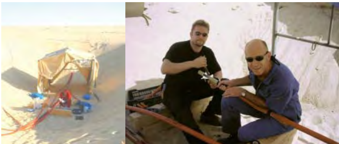
SMX 52 kV, Libya.
