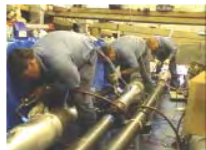
SMPGB 170 kV, Australia.
