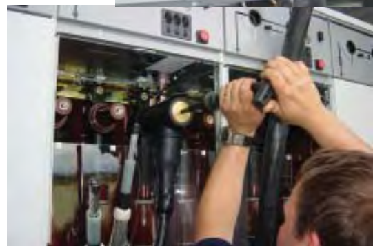
SOC 630 A in Holec switchgear, Sweden.
